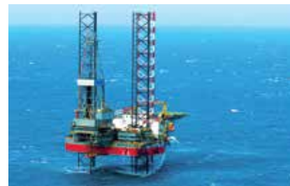
Giàn khoan tự nâng PV Drilling II. Ảnh: PVN
